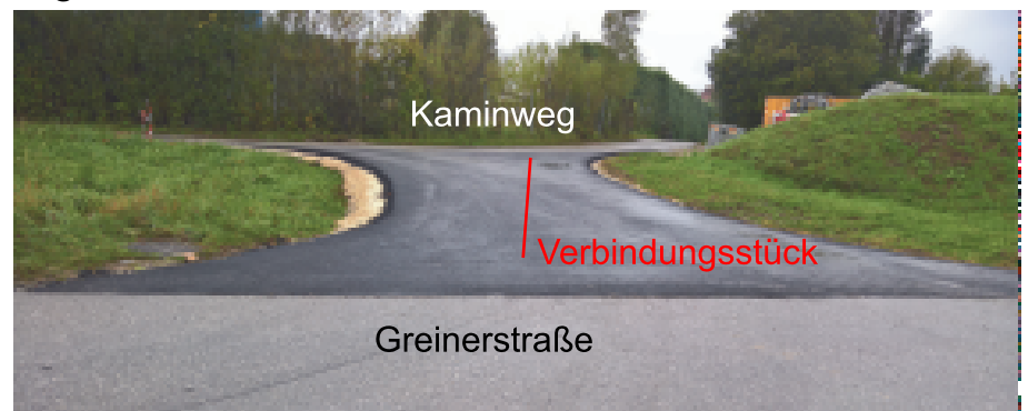
Foto: Gemeinde; Verbindungsstraße fertiggestellt
