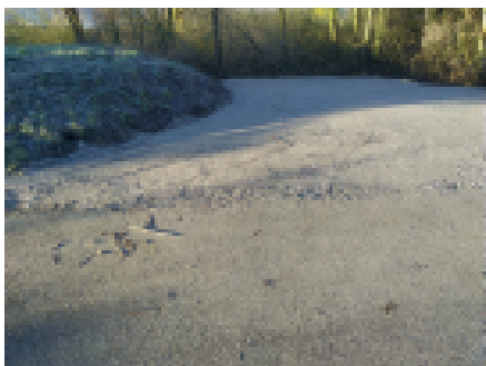
Umkehrplatz im Kaminweg; Foto: Ing. Gerhard Gebeshuber
