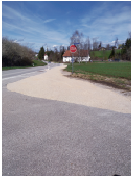
Saniertes Bankett zwischen der Pernsteinerstraße und dem Ofenschüsselbach
