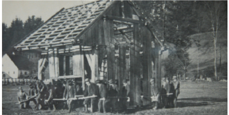
Versetzen des Stadls der Ranklmühle, der am 12.1.1937 wegen des Straßenbaus auf den Bäckerwimmerberg weichen musste. Foto: Gemeinde Nußbach
