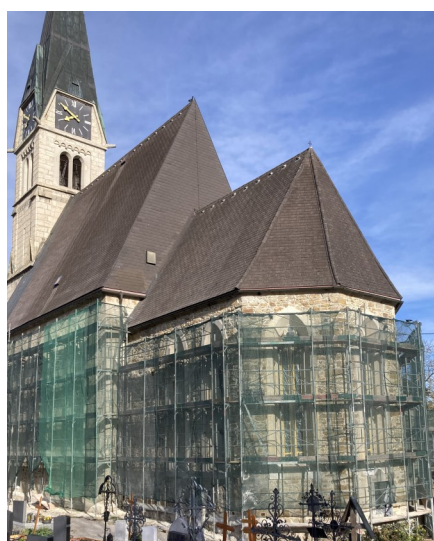
Sanierung der Fassade.
